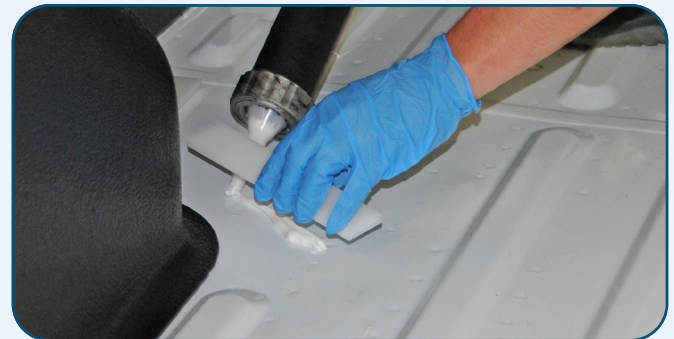
Mise en place de l'entretoise en plastique
